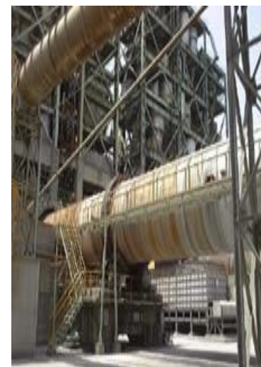
▲生料&煤磨風機 安川變頻器 2,000kW
