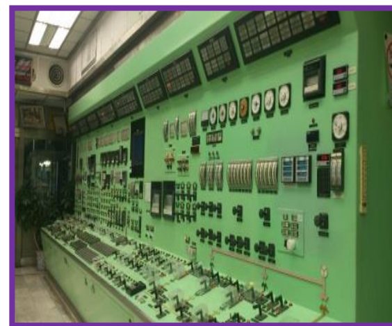
▲發電廠送風機&循環風機 安川變頻器 4,500kW 5
